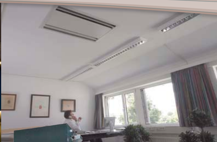
PLFY-P VLMD Cassette unit 2-zijdig uitblazend
