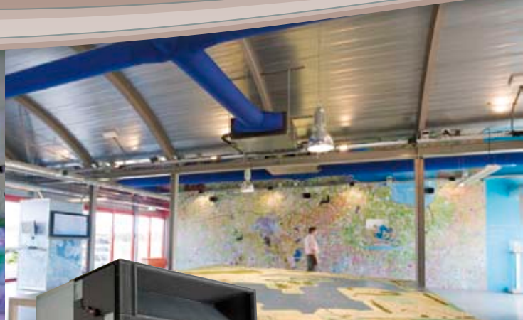
PEFY-P VMH Kanaalunit met luchtverdeelsslangen
